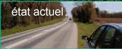
Cas B2 (rives non marquées) : Couche de roulement existante de 7,60m : chaussée ramenée à 6m et 2 BDM de 0,80m
