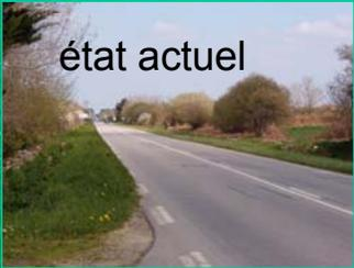
Cas B1 (rives marquées) : Couche de roulement existante de 7,30m : chaussée ramenée à 6m et 2 BDM de 0,65m
