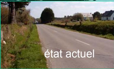
Cas B4 : Couche de roulement existante inférieure à 7m et rive non marquée : chaussée ramenée à 6m et 2 BDM de 0,80m
